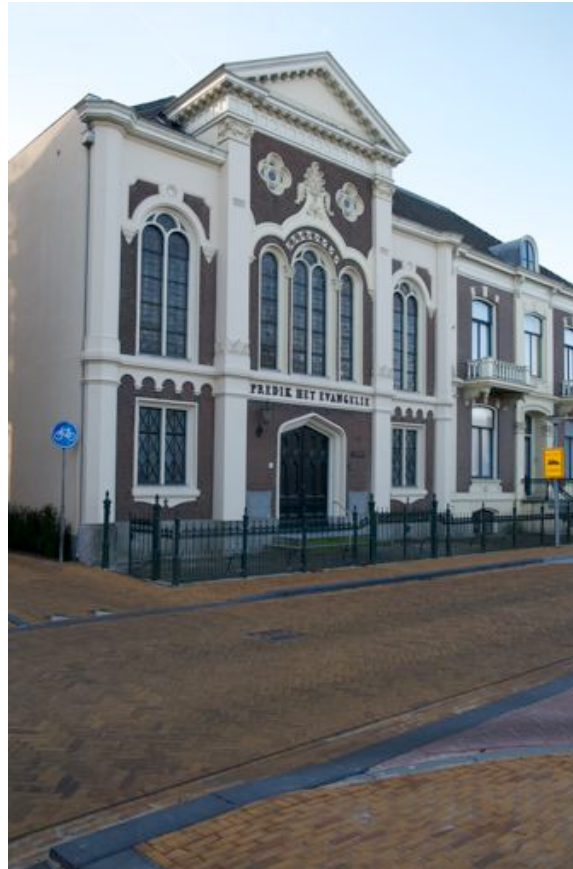
Kerkgebouw 'Predik het Evangelie' met naastgelegen pastorie. Deze gebouwen werden in 1880 op initiatief van Ds. Van Dijk aan de Burg. Van Nispenstraat gebouwd.
