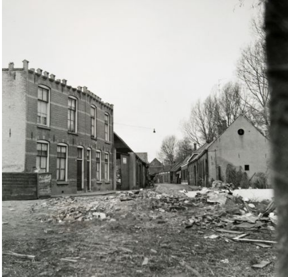
Een omstreeks 1970 door Louis Putman gemaakte foto van de Nieuwstad, de sanering van de muurhuizen is dan in volle gang (Collectie Stadsmuseum Doetinchem).
