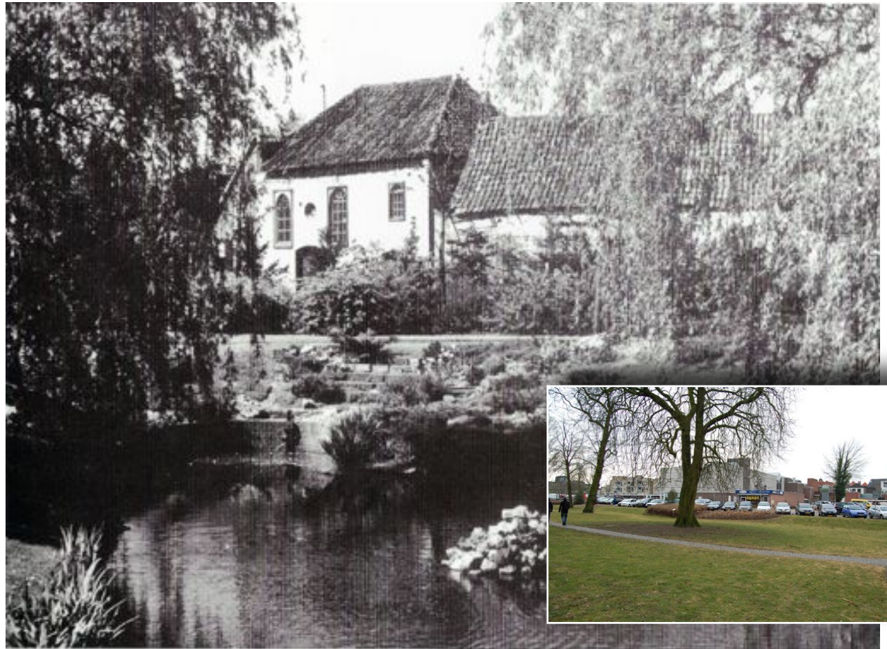
Aan de Nieuwstad, ter hoogte van V&D, stond tot 1972 de oude synagoge. Het verwaarloosde gebouw was tot de afbraak in gebruik als pakhuis. Op de inzet de huidige situatie.
