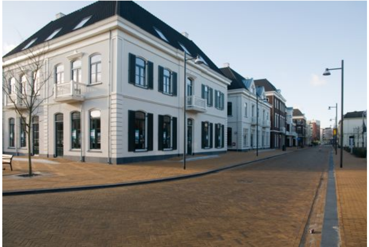
Overzicht van het recent aan de Burg. Van Nispenstraat gereconstrueerde bouwblok.
