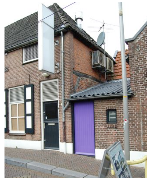
Restant van een houten vakwerkconstructie, ingemetseld in de eindgevel van Synagogestraat 7.
