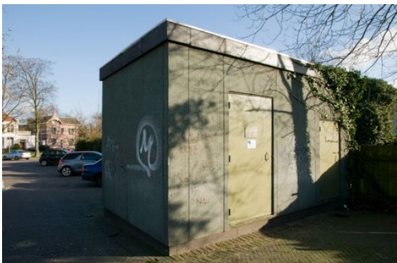
Prefab trafohuisje van de PGEM, waarschijnlijk in de jaren '70 op een parkeerterrein aan de Nieuwstad geplaatst.
