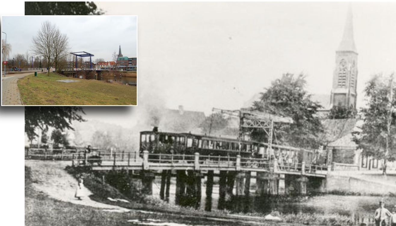
Stoomtram met enkele wagons op de brug over de Oude IJssel. Foto uit het begin van de vorige eeuw. Op de inzet is de huidige situatie weergegeven.
