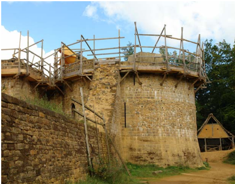
Vliegende steiger bij de bouw van een ronde toren van de reconstructie van het 13 de eeuwse kasteel in Guedelon.
