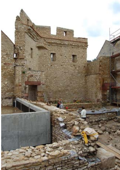
Op de voorgrond nieuw kistwerk in uitvoering bij de reconstructie van de Karolingische palts in Ingelheim.
