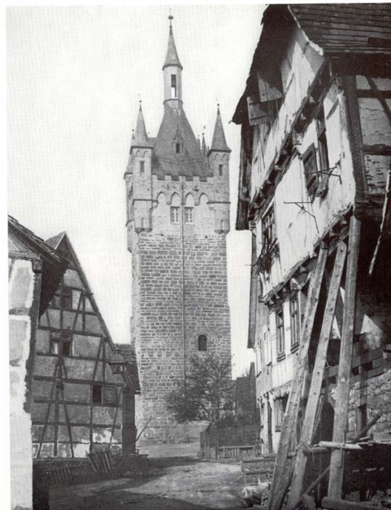
Foto van de Blauwe toren uit het begin van de vorige eeuw waarop de dichtgezette balkgaten van de galerij die behoorde bij de verdwenen buitentrapp nog goed zichtbaar zijn.
