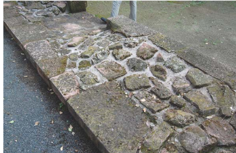
Gereconstrueerd muurdeel in kistwerk in de palts in Gelnhausen.
