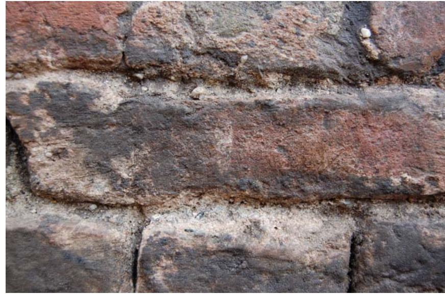
Detail van het metselwerk van een bij een opgraving in de Bruggenstraat in Harderwijk aangetroffen 13 de eeuws huis (XIIIb), waarvan de onderverdieping opgetrokken is in baksteen. De zeer grote bakstenen (10-lagenmaat 100 cm en meer) hebben oorspronkelijk een rode afwerking waarop witte schijnvoegen aangebracht zijn. Het oppervlak is waarschijnlijk later afgedekt met een dunne (gekleurde) pleisterlaag.
