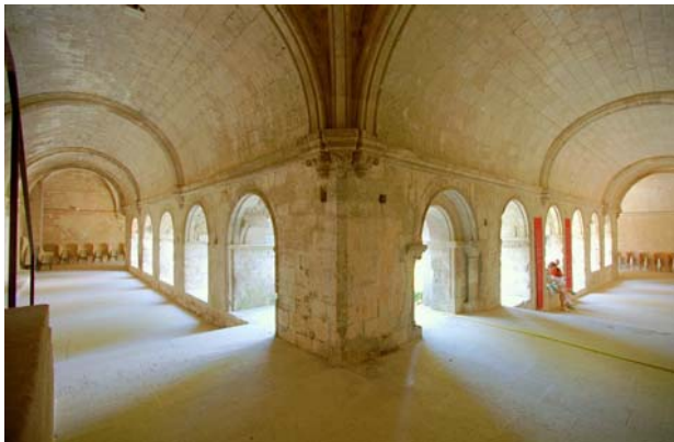
Met een eenvoudig tongewelf overwelfde kloostergang, daterend uit de tweede helft van de 12 de eeuw in het zuid-Franse Le Thoronet.
