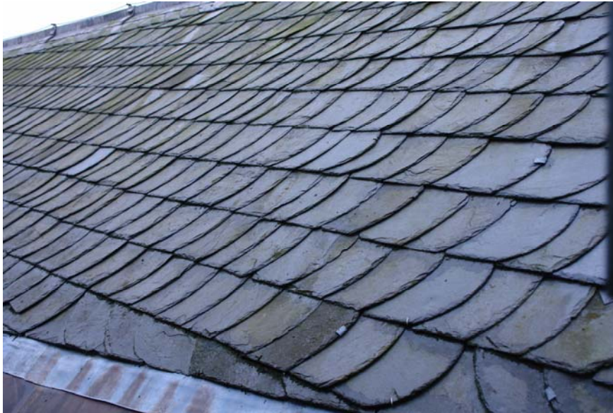
Met onregelmatig gevormde schubleien uitgevoerd dak in de zogenaamde Oudduitse dekking.
