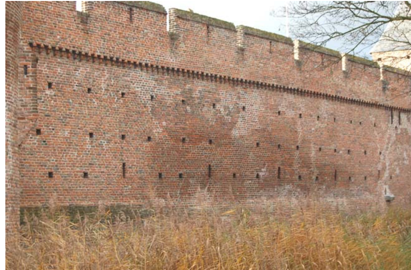
Open kortelinggaten in de weermuur van de voorburch van kasteel Doornenburg.
