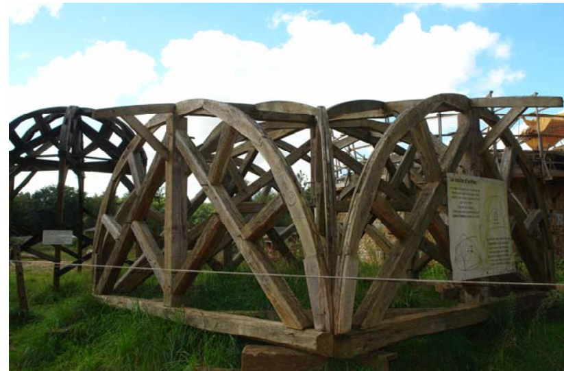
Formelen toegepast ten behoeve van de constructie van een kruisribgewelf bij de reconstructie van het 13 de -eeuwse kasteel in Guedelon.
