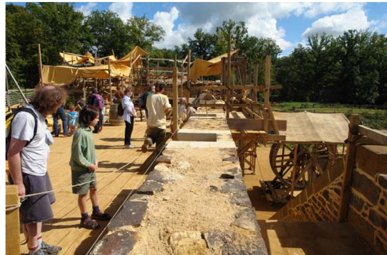
Pas gesteld muurdeel in de reconstructie van het 13 de eeuwse kasteel in Guedelon.
