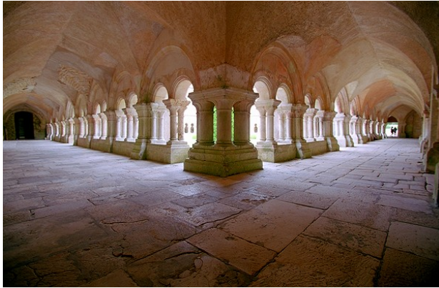
Boven: kloostergang in het Cisterciënzer klooster in Fontenay, daterend uit de periode 1139-1147. Toegepast is een zesdelig ribloos kruisgewelf.
